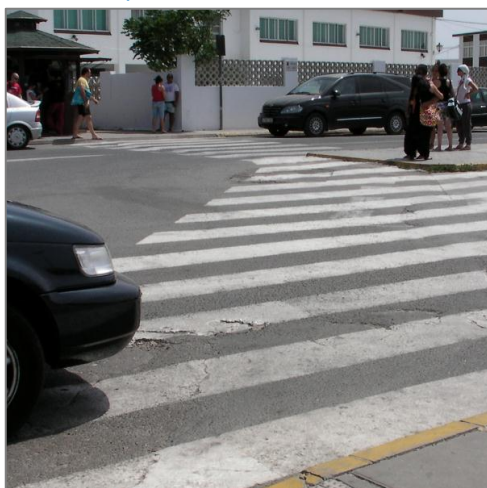
Paso de peatones sobre Avda. del Río
